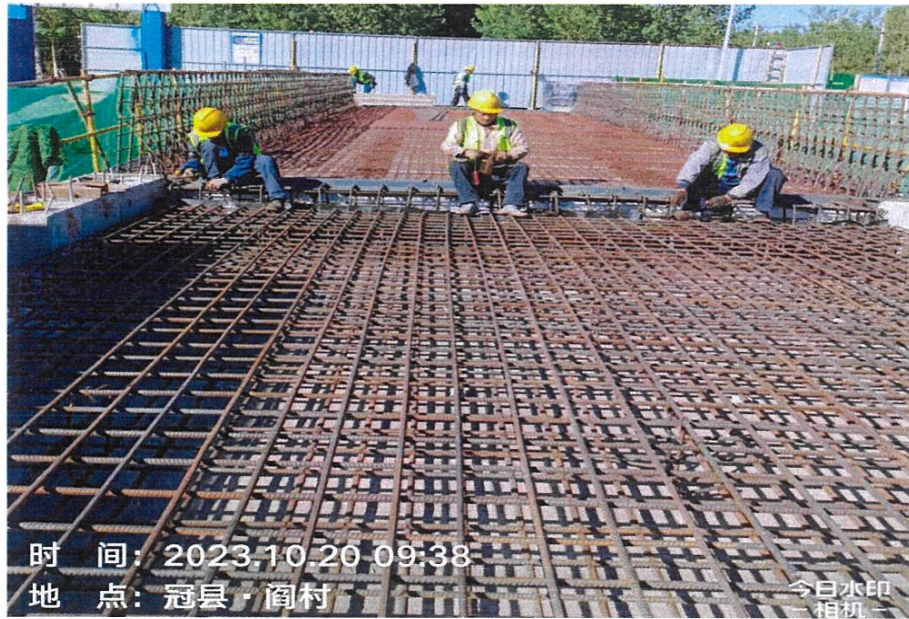
图二 桥面钢筋铺设现场施工照片
