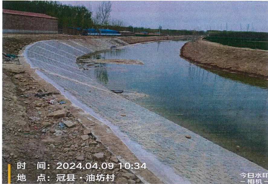
图三 护砌段完工照片
