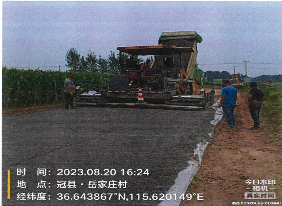
图一 防汛路建设现场施工照片
