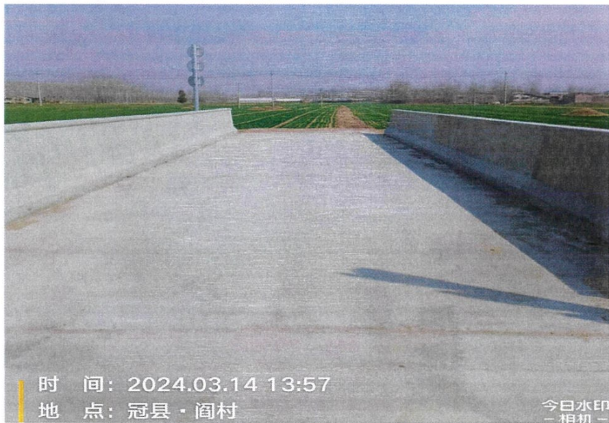
图四 阎村桥建设完工照片
